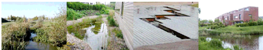
Le traitement alternatif vise à collecter les eaux de pluie là où elles tombent avant même qu'elles ne ruissellent.
