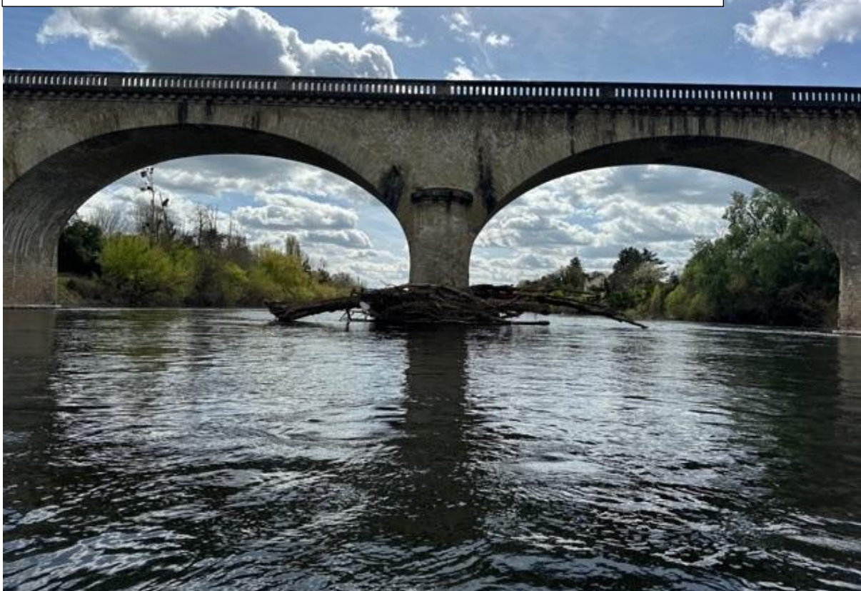
4 – embâcle au niveau d'une pile du pont SNCF de Sainte-Foy-la-Grande
